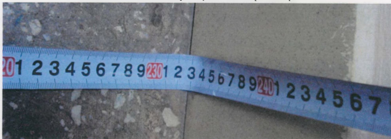
Ширина коридоров примерно 232 см в среднем \pm 3 см по этажам (пример)
