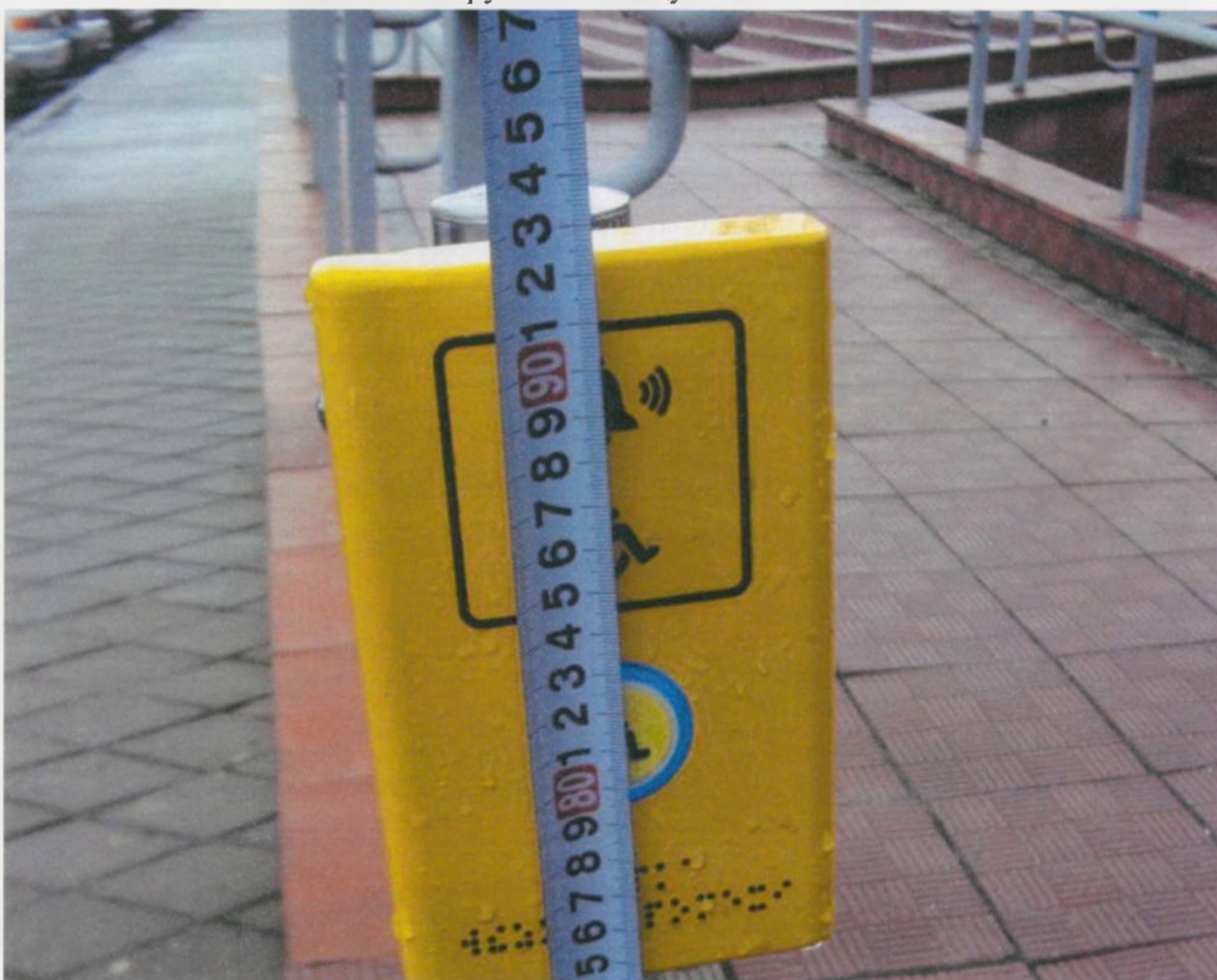
Высота размещения кнопки вызова персонала наружного пандуса окольного этажа
