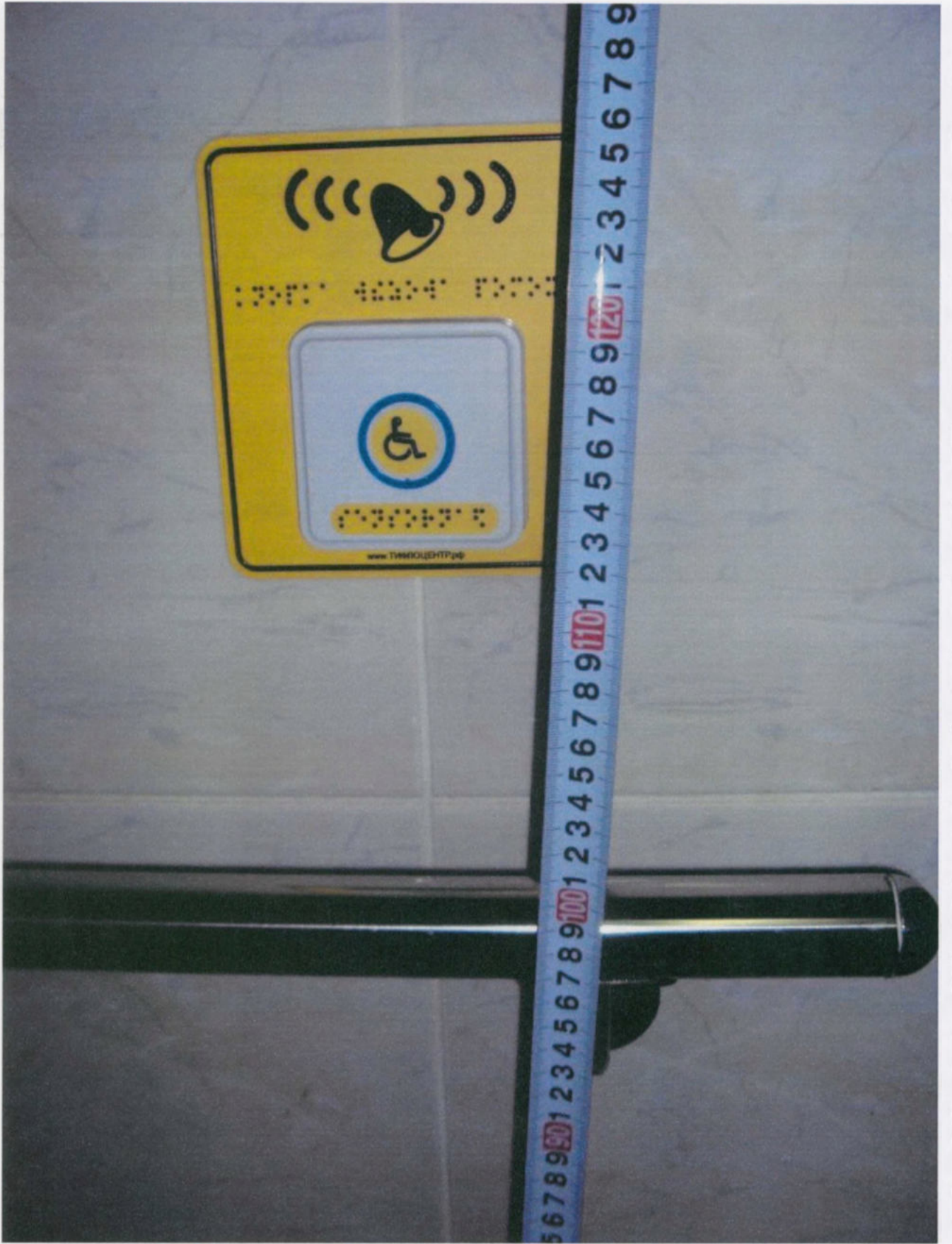
Кнопка вызова помощи внутри санузла и поручень
