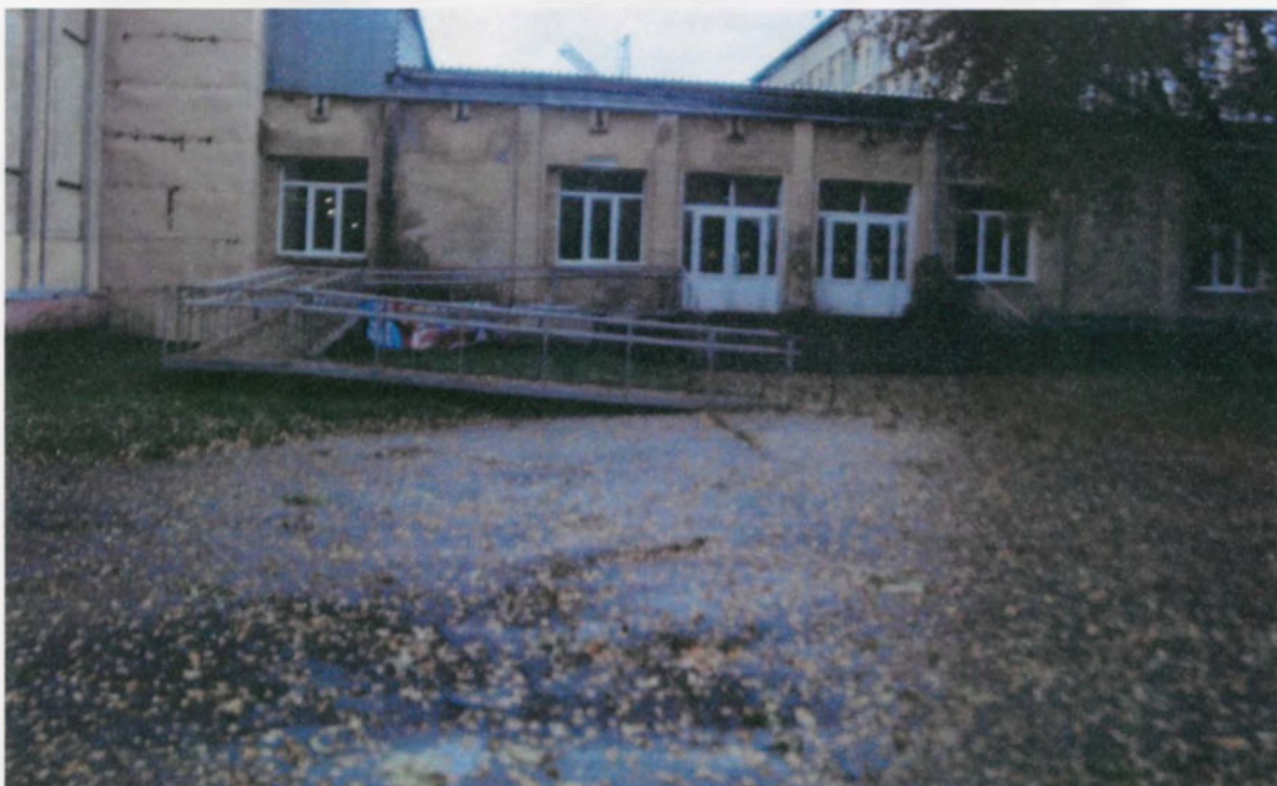
Общий вид наружного пандуса первого этажа
