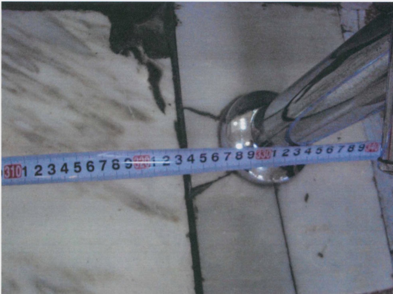
Ширина лестницы с цокольного этажа на первый
