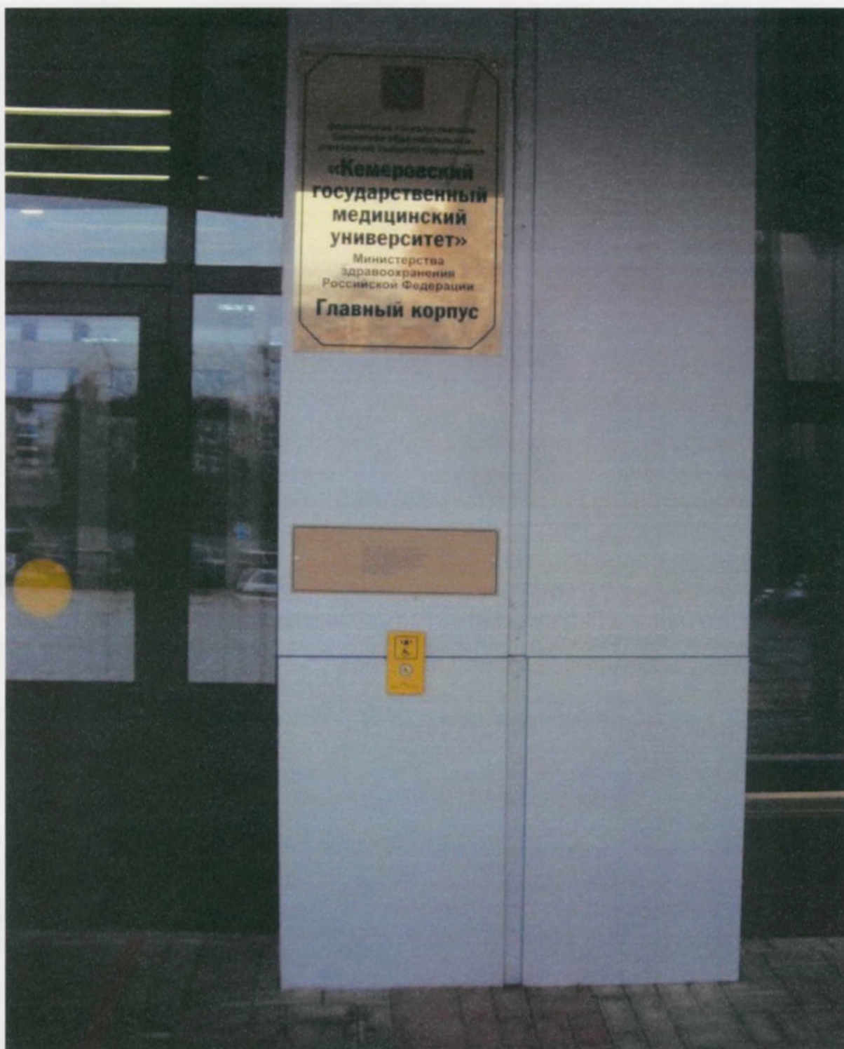
Таблички с наименованием учреждения, в том числе с шрифтом Брайля и кнопка вызова помощи персонала
