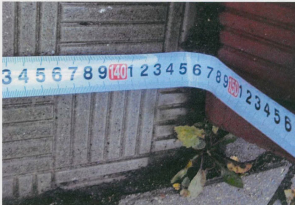
Ширина наружного пандуса цокольного этажа (2 секция)
