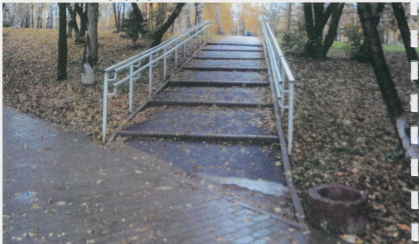
Подъём на пути следования по тротуару
