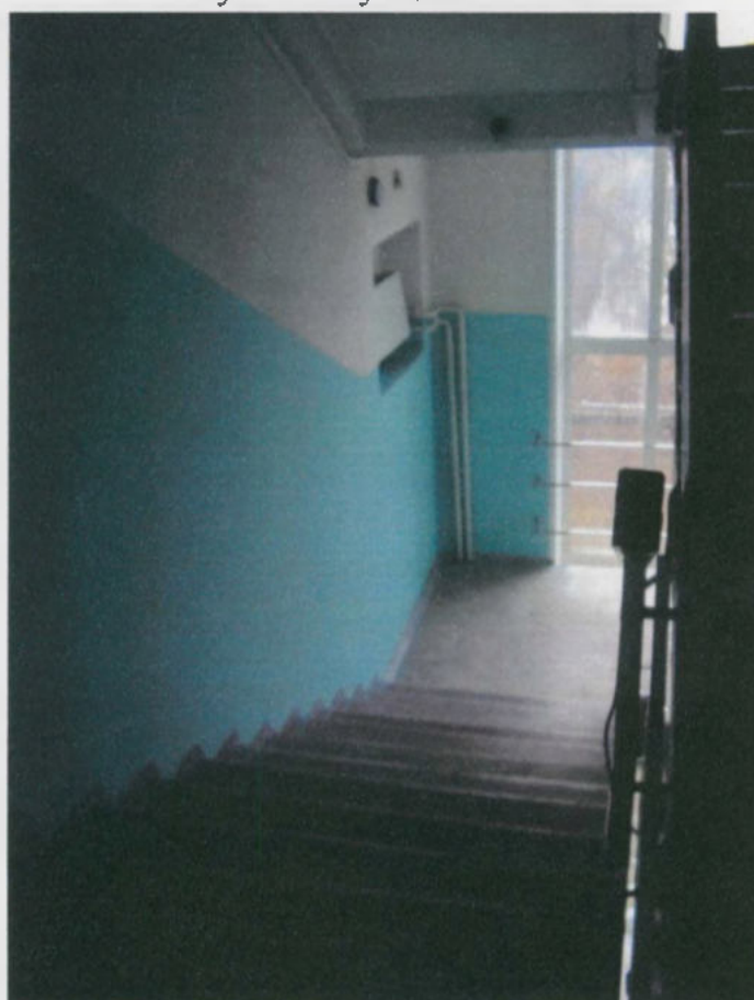
Вид лестничного марша эвакуационного пути (пример)
