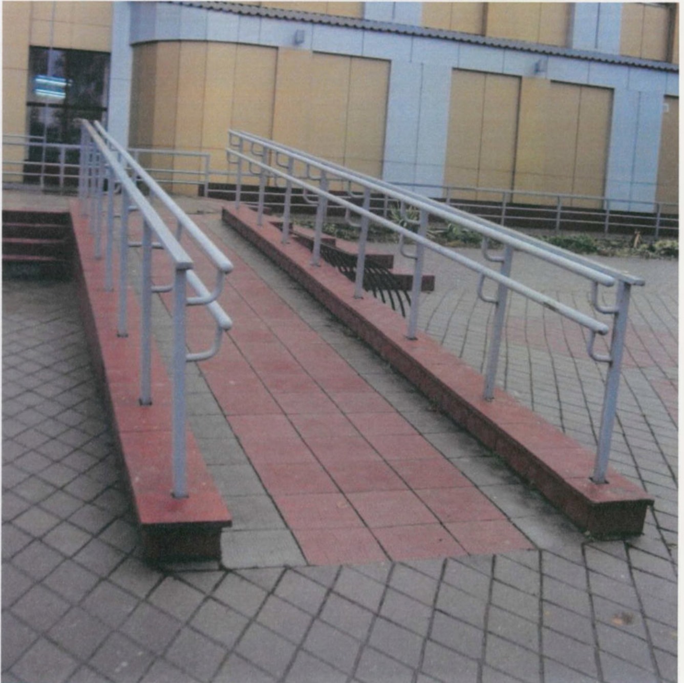
Общий вид наружного пандуса цокольного этажа (2 секция)
