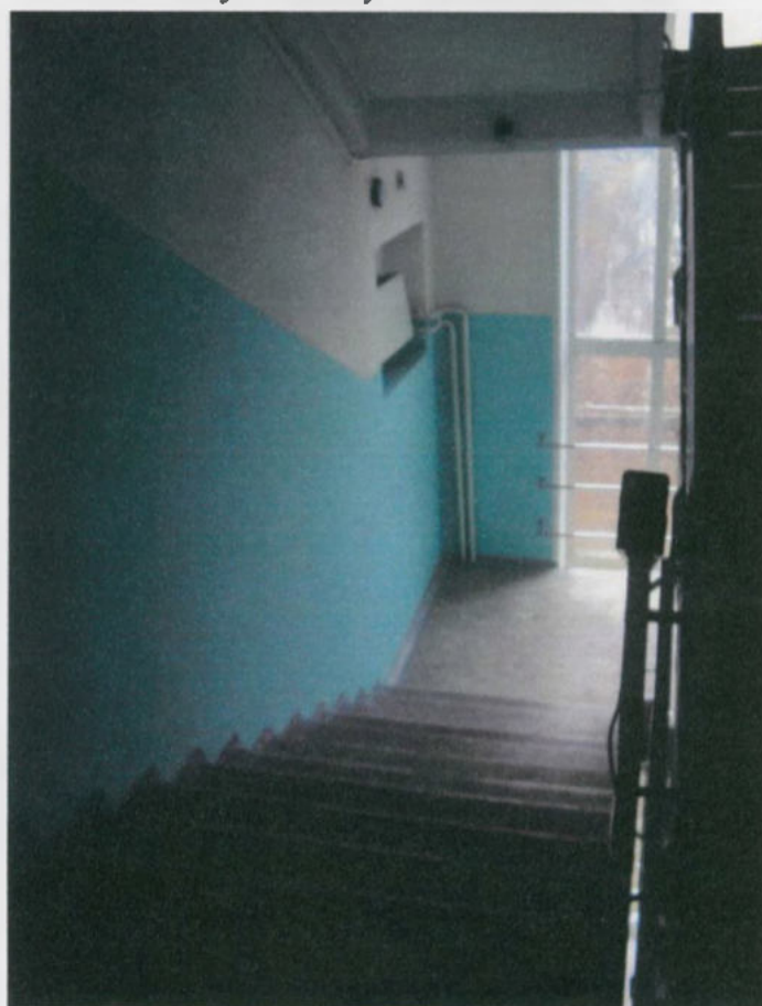
Вид лестничного марша эвакуационного пути (пример)
