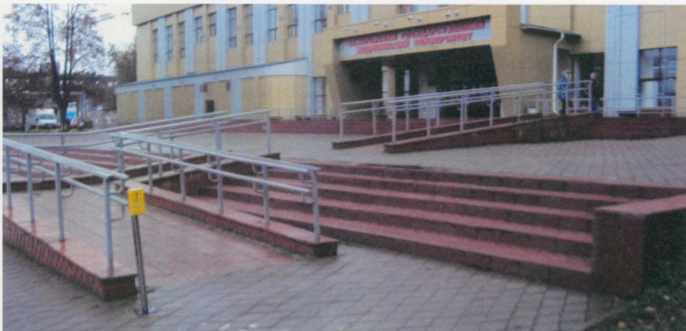
Общий вид наружного пандуса окольного этажа
