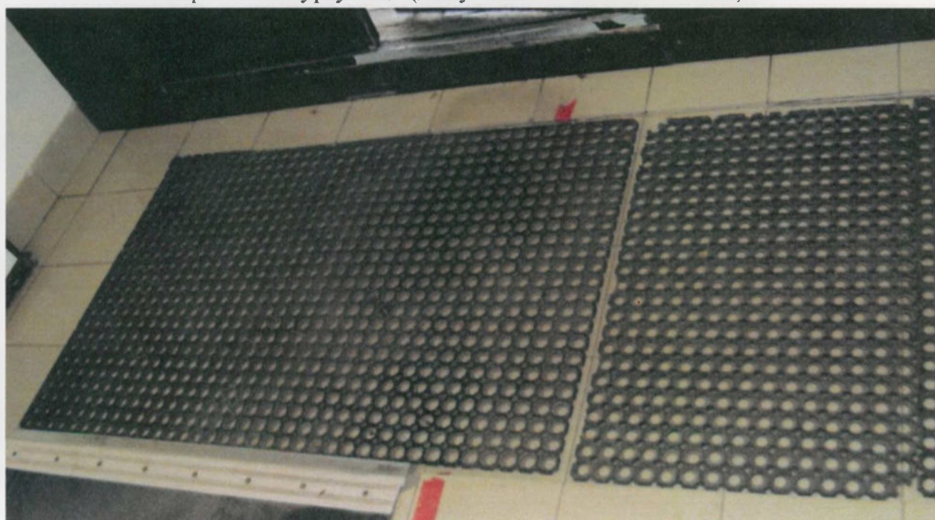
Грязезащитное противоскользящее покрытие тамбура
