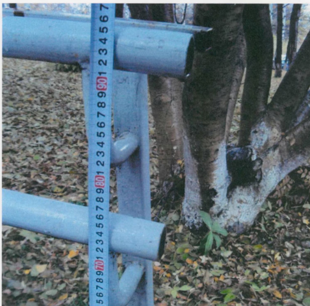
Высота поручня на подъёме тротуара
