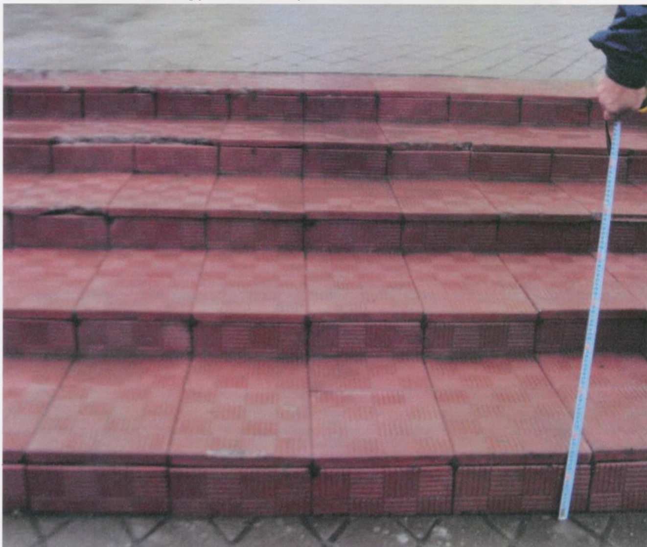
Вид наружной лестницы цокольного этажа 1 секция (5 ступеней)
