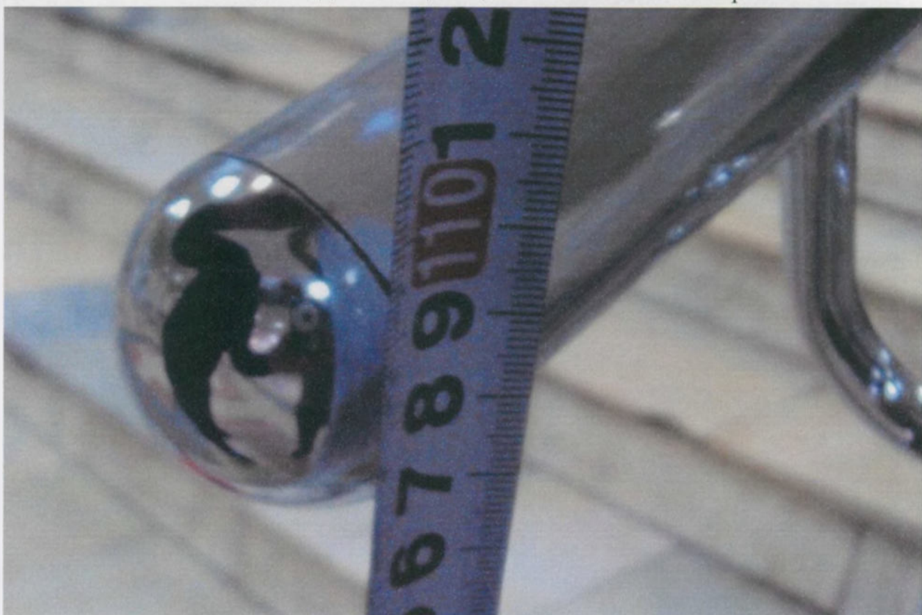
Высота поручня лестницы с цокольного этажа на первый
