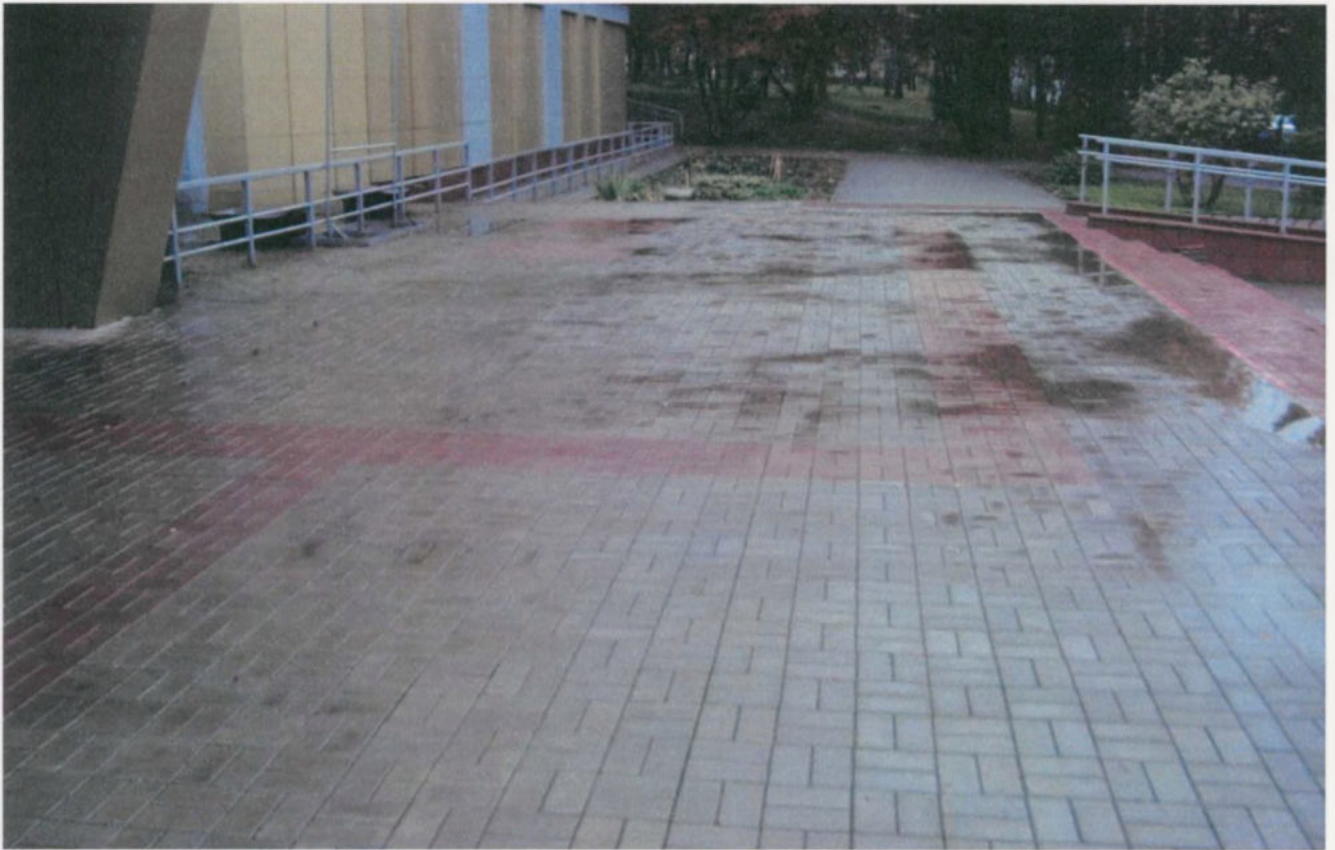
Общий вид площадки перед входом на цокольный этаж
