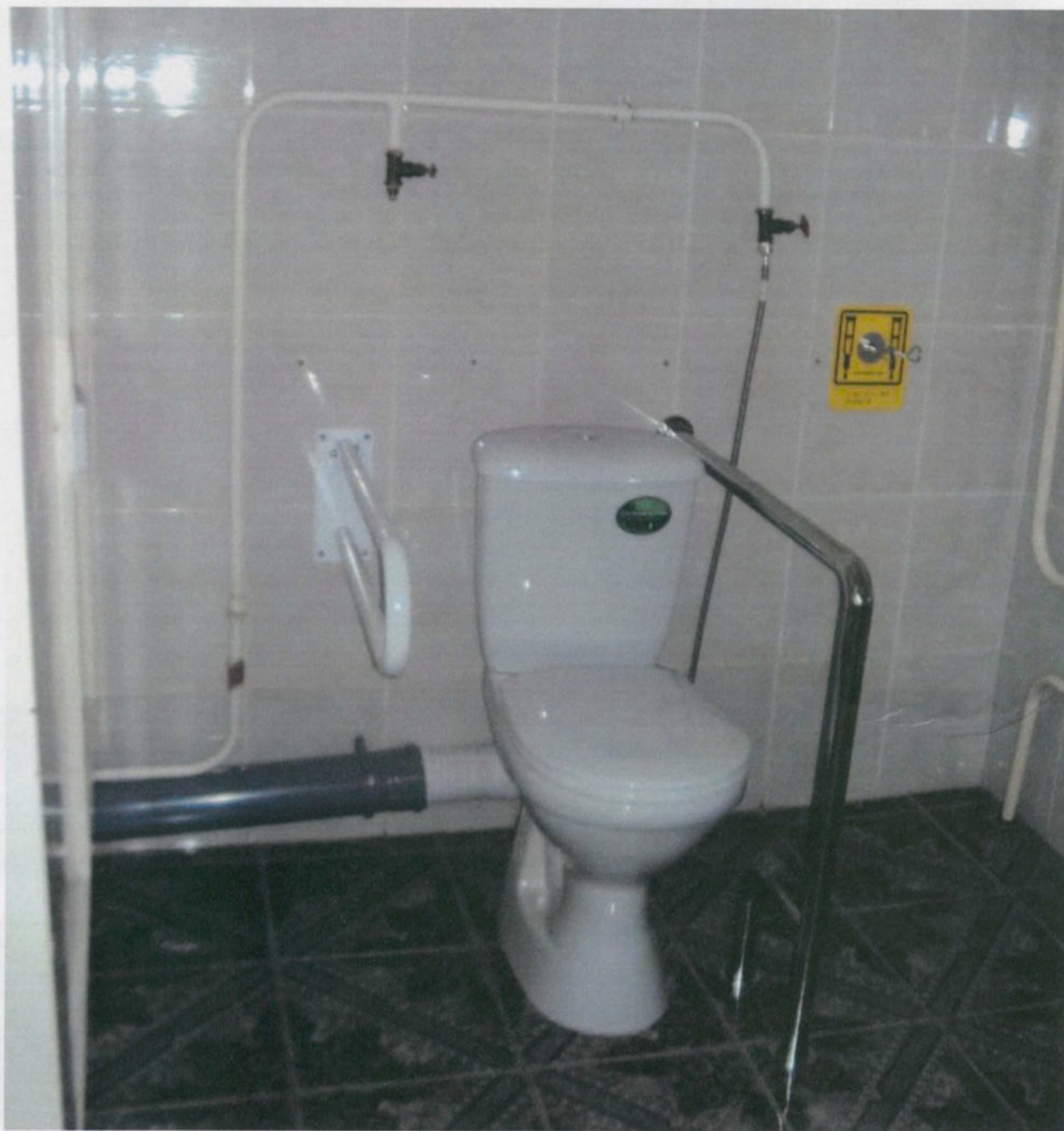
Общий вид оборудованного санузла
