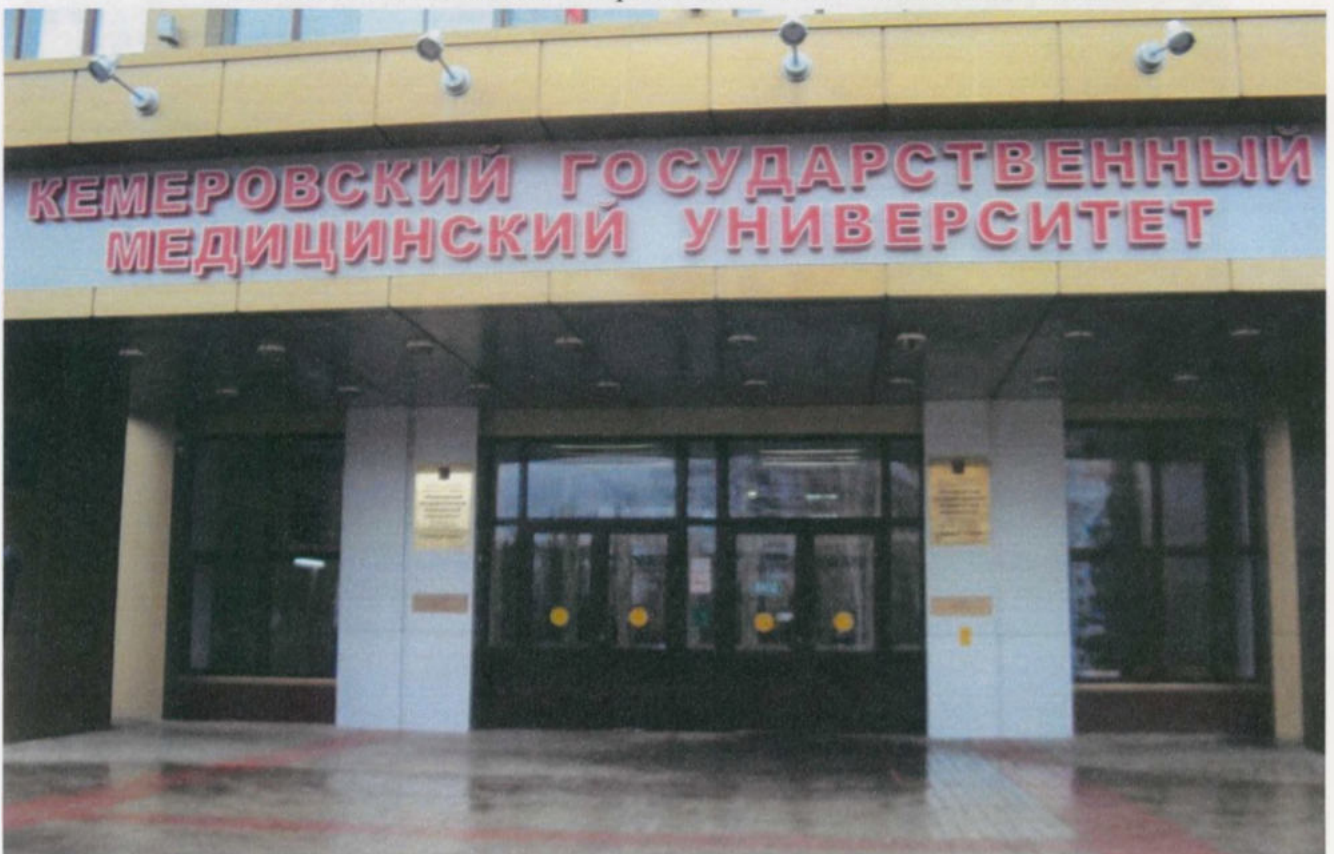
Общий вид входа на цокольный этаж
