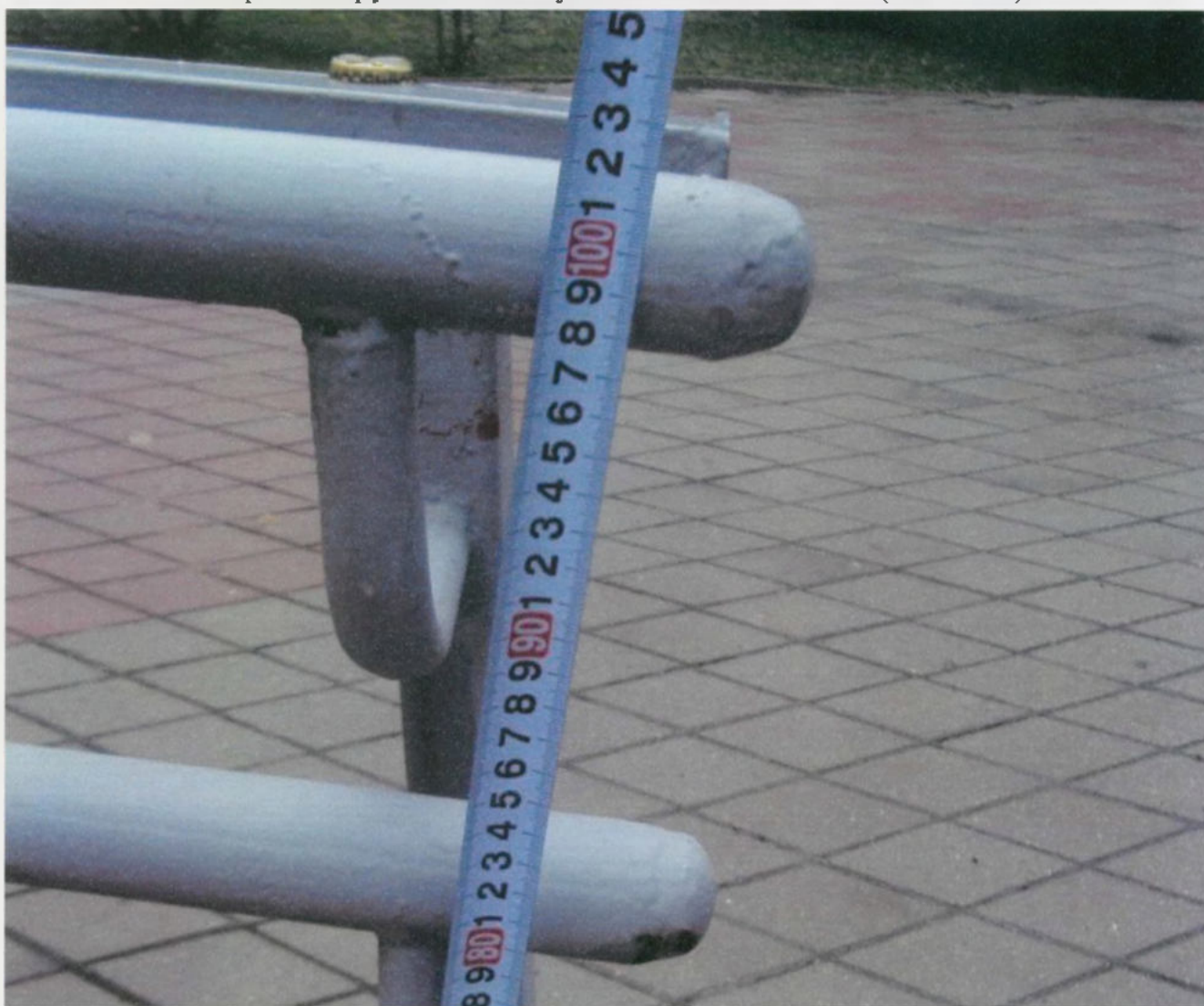
Высота поручня наружного пандуса цокольного этажа 2 секция (верхнего и нижнего поручня)
